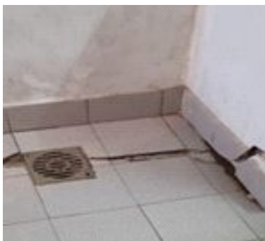
Travaux de rénovation
