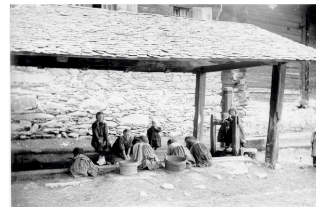
Salvan, Fonds André Guex, Médiathèque Valais Martigny
