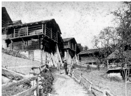
Granges O. Nicollier / Médiathèque Valais
