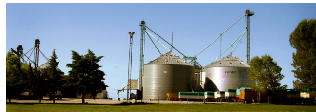
Silos à grain très répandus en Argentine
